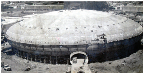
PROJET EN COURS DE LA COUPOLE DU COMPLEXE OLYMPIQUE DU 5 JUILLET
